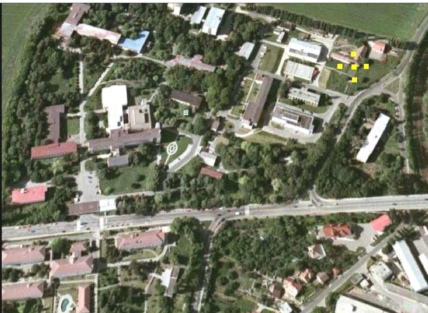
Etapová stavba víceúrovňového parkoviště nemocnice, Kyjov návrhy 2004-5
